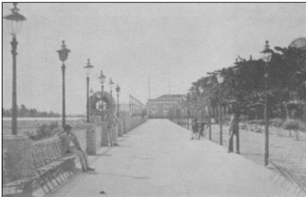
Avenida Caio Prado, no Passeio Público, do lado do mar, com gradil de ferro separando o 2o plano e dezenas de combustores. Foram colocadas também dezenas de cadeiras. Foto para exposição de Chicago, em 1893.
