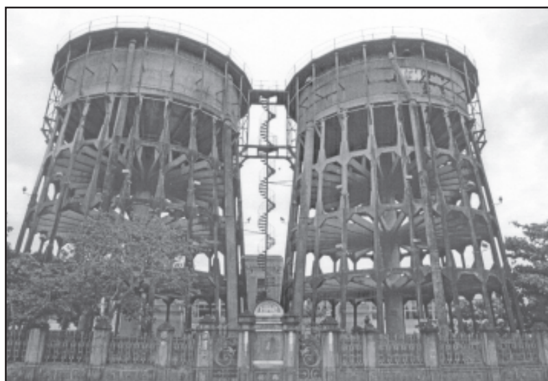
Caixas d'água na Praça Visconde de Pelotas, no Benfica, trabalho de abastecimento de água de Fortaleza interrompido por 13 anos. Foto: Dário Gabriel.
