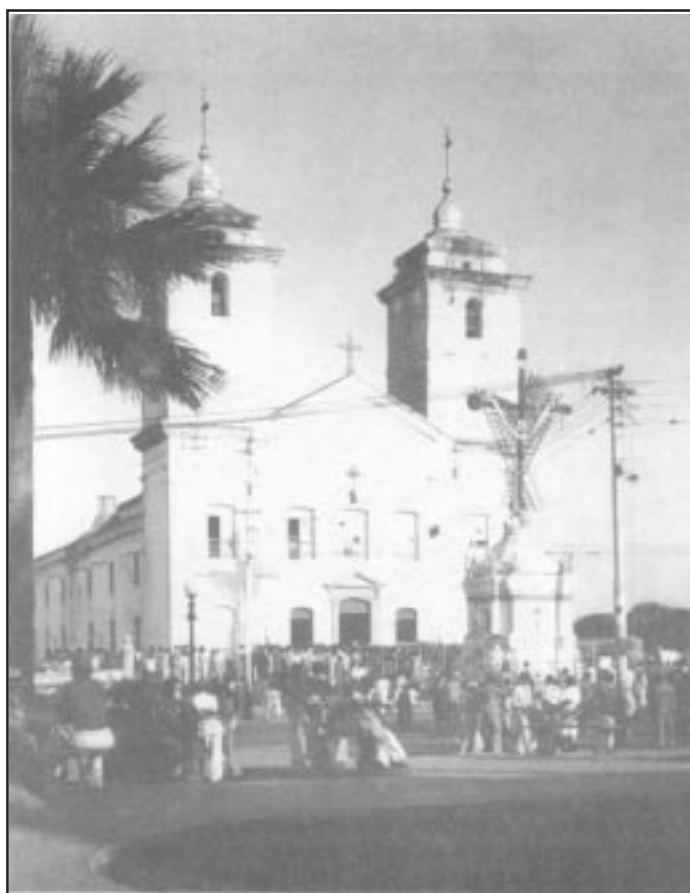
Última missa na Catedral Metropolitana de Fortaleza (Igreja de São José), sendo transferida a imagem de São José para a Igreja do Rosário, para ser iniciada sua demolição (Foto Aba Film).
