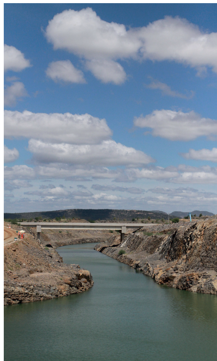
Canal da barragem de Jati, entrada das águas do Velho Chico
