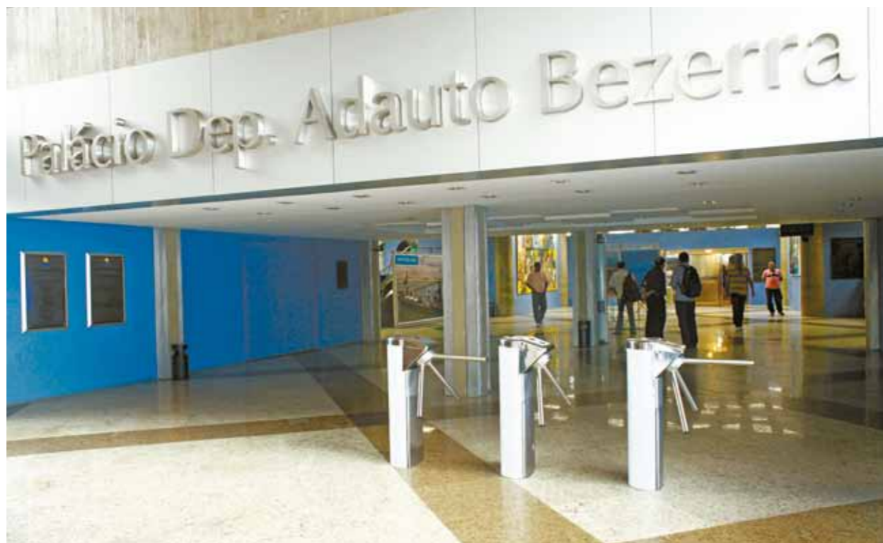
>> Catracas já estão sendo montadas nos principais acessos ao prédio do Legislativo.
